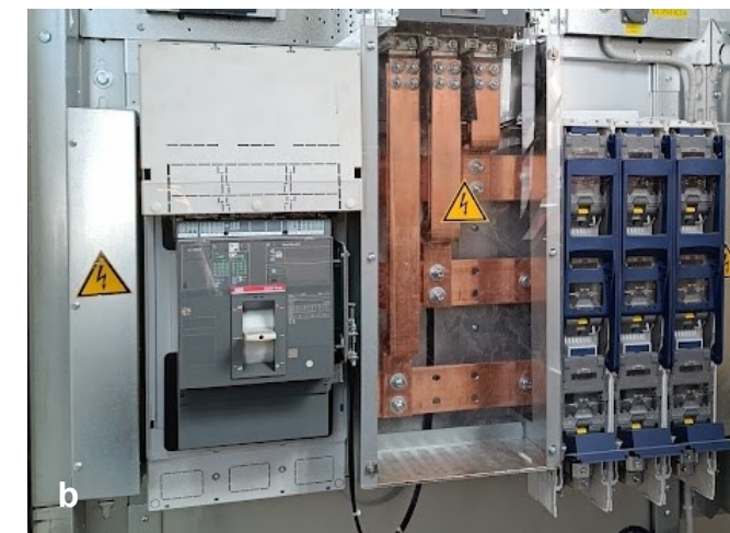
7.5.1. att. Aizsargslēdzis uz 185mm adaptera: a– adapteris; b– aizsargslēdzis ST tipa sadalnē
