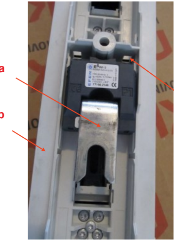
6.2.1. att. Strāvmaiņš E3W1-3: a– slēdža kopņu spaiļe; b-slēdzis(skats no kopņu pievienojuma puses);
