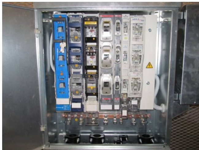
7.0.1. att. Sadalnes paraugs ar dažādu ražotāju slēdžiem
